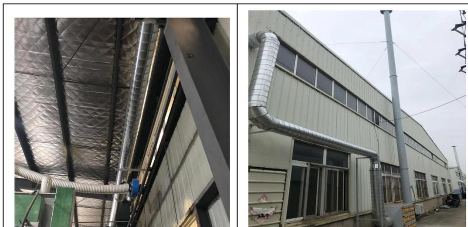
发泡工序集气+净化+15m 排气筒装置
