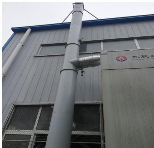
封闭式拌料房+布袋除尘器+15m 高排气筒
