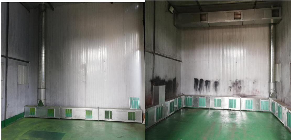
密闭喷/烤漆房+集气系统+干式过滤棉
