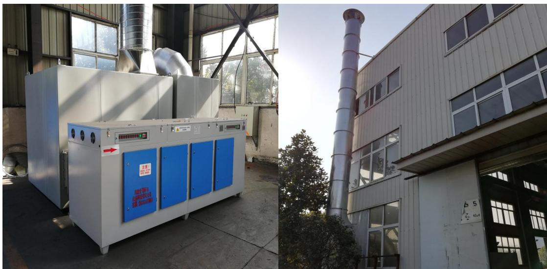
UV 光解+活性炭吸附废气处理装置+15m 高排气筒（FQ-001）
