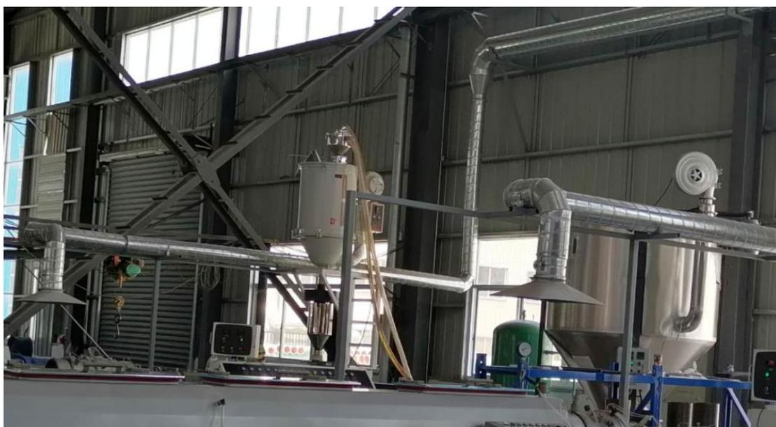
HDPE 管生产线有机废气收集系统+活性炭吸附装置+15m 高排气筒有组织排放
