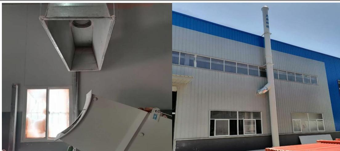
破碎、磨粉粉尘经封闭破碎房+集气罩+布袋除尘器+15m 高排气筒有组织排放
