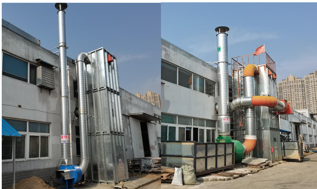
集气系统+中央除尘器（1号、2号）+15m 排气筒（DA001、DA002）
