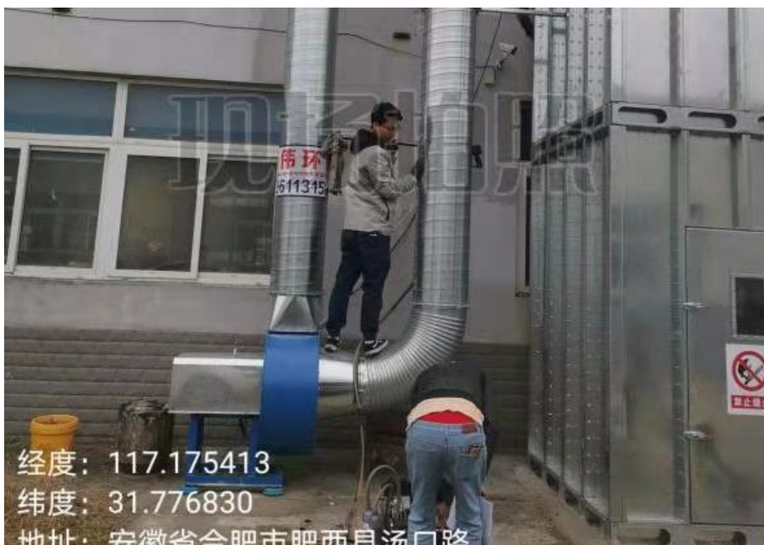
现场监测取样照片
