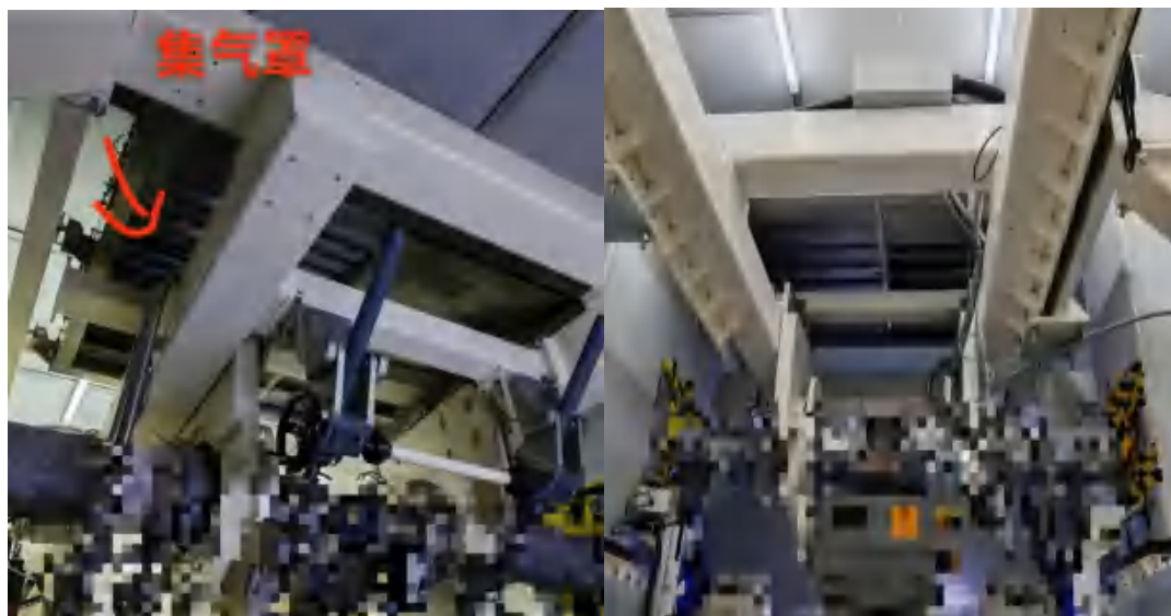
气收集系统（密闭房间+集气罩）
