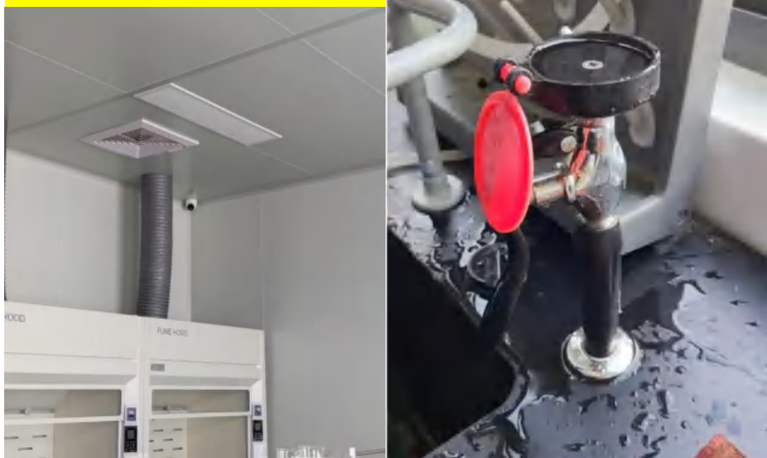
视频监控器+紧急冲淋装置
