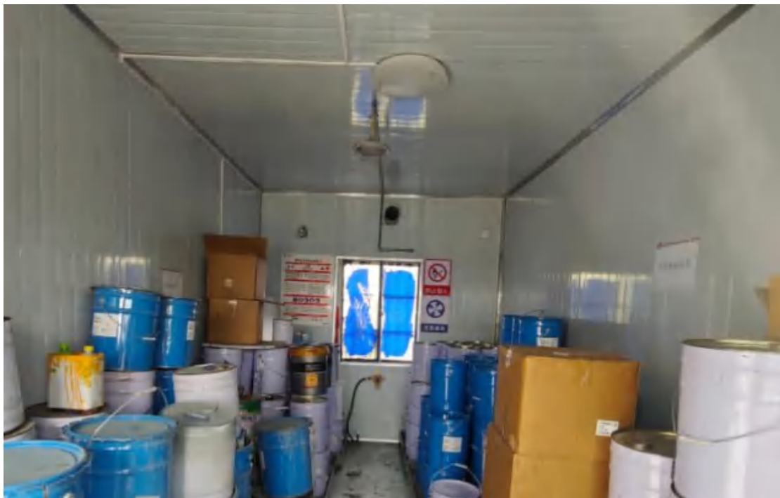
化学品库（可燃气体报警器、防爆灯、废气收集、标识）
