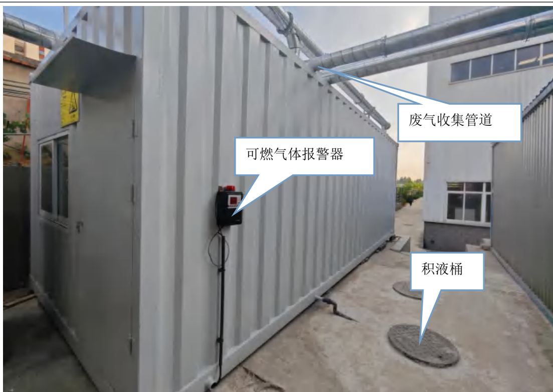
危废仓库（地下积液桶、废气收集管道）
