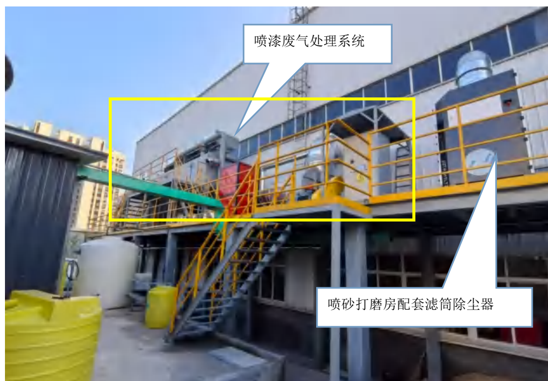
喷漆废气处理系统（旋流塔+干式过滤+活性炭吸附脱附+CO 工艺）、喷砂打磨房配套滤筒除尘器
